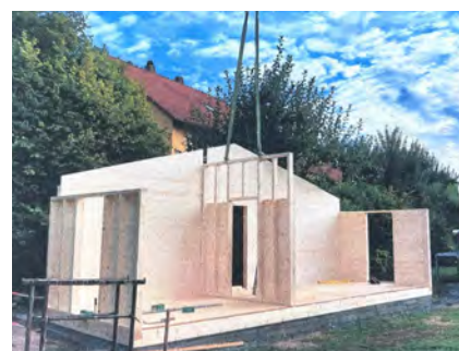
◆ Aufstellen der Innenwände
