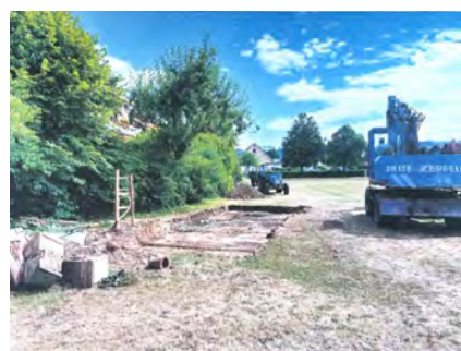
◆ Der Bau der Grillhütte kann beginnen.
