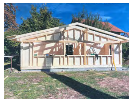
◆ Der Rohbau steht.
